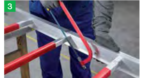
Beschädigte Sprosse im Abstand von ca. 20 mm von der Holminnenkante heraussägen.
