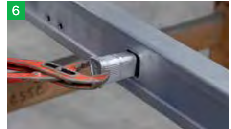
Das zusammengedrückte Sprossenteil aus der Leiter entfernen.
