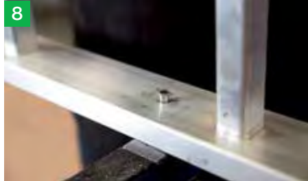
8 Sicherungsscheibe auflegen
