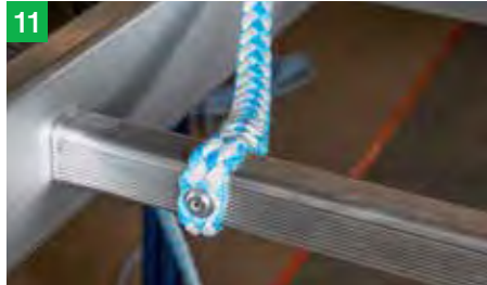
11 Fertig erneuertes Zugseil
