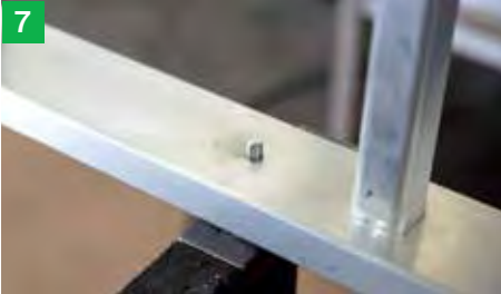
7 Leiter umdrehen, Bolzenkopf muss auf dem Arbeitsbock aufliegen
