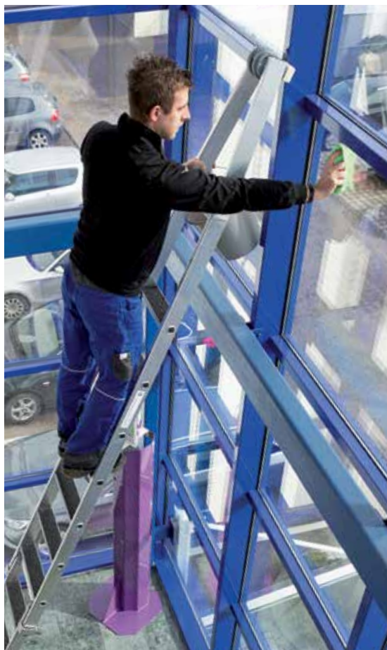
Wird eine Leiter als Arbeitsplatz genutzt, sind Stufen vorgeschrieben.
