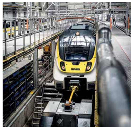
Dank der Plattformverlängerungen können die Arbeitsplattformen mit Spaltmaß Null am Zug andocken.
