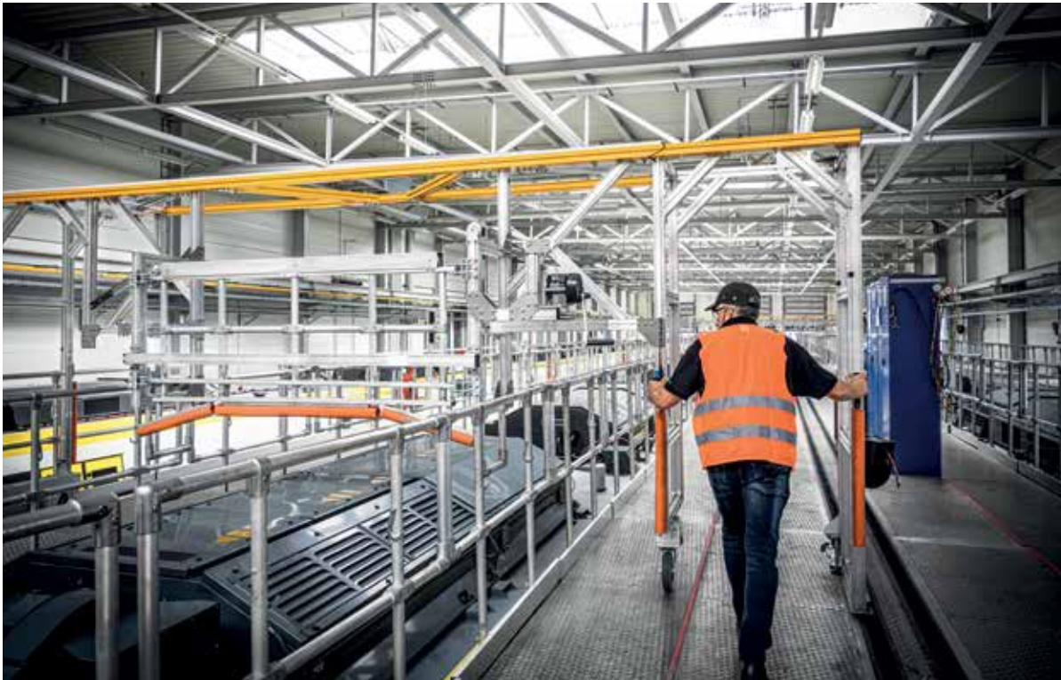
Die Quergeländer lassen sich per Totmannprinzip entlang der Gleise verschieben.
