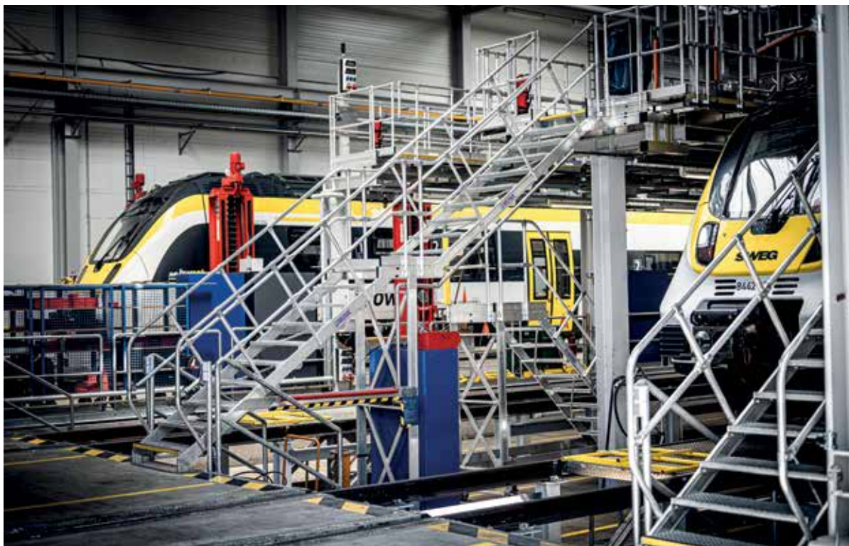
Vier Treppen mit 900 mm breiten Stahl-Gitterrost-Stufen mit R13-Rutschhemmung und Handläufen sorgen jederzeit für sicheren Auf- und Abstieg auf die Dacharbeitsbühne.
