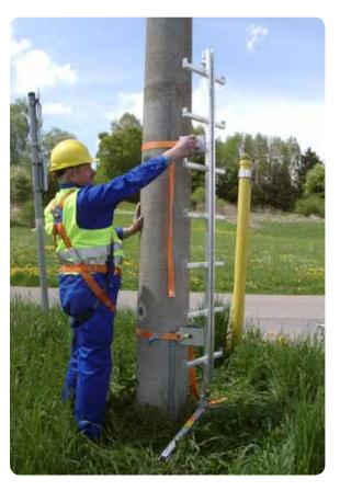
Unteren Spanngurt lösen.
