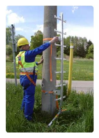
Sicherungsläufer von unten in die Führungsschiene einschieben. Beachten Sie die Kennzeichnung "oben" und "unten" am Sicherungsläufer.
