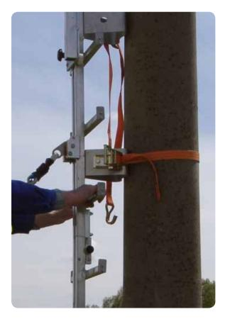
Oberen Spanngurt wie vorhergehend beschrieben am Mast befestigen. Befestigung des Leiterelemtens prüfen.
