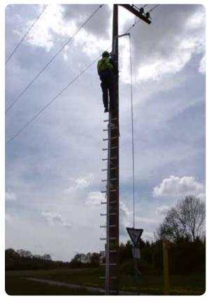
Leiterelement mit der Aufzugsvorrichtung nach unten ablassen.
