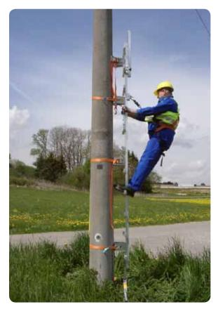
Aufzugsvorrichtung nach oben schieben. Das nächste Leiterelement kann mit der Aufzugsvorrichtung nach oben gezogen werden.
