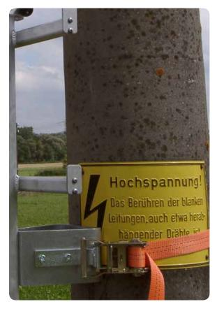
Spanngurt mit der Hand spannen. Durch Auf- und Abbewegen des Spanngriffs an der Ratsche wird das Gurtband gespannt. Nach 2 Umwindungen sollte das Leiterelement am Mast fest sein
