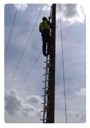
Zur Demontage muss der obere Spanngurt gelöst werden. Das Lösen des Spanngurts erfolgt durch ziehen der Sperrklinke und gleichzeitigem Umlegen des Spanngriffs in die 180° Stellung. Spanngurt etwas zurückziehen und Sicherungshaken aushängen.
