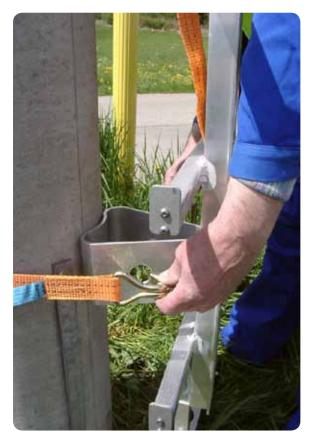
Einhängehaken des Spanngurts in die Bohrung des Abstandshalters einhängen.
