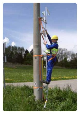
Sicherungsläufer von unten aus der Führungsschiene entnehmen.
